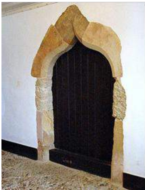
Fig. 12. Arco contracurvado do antigo vão de acesso à sala de orações da Sinagoga de Tomar.
