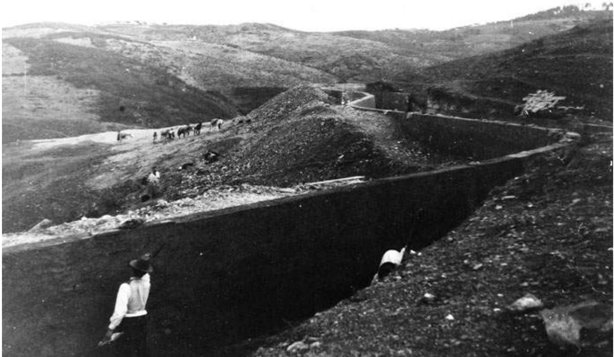
Imagem 28 – A dificuldade da obra, construída num terreno inóspito que em muitos casos não conhecia mão humana, está bem patente nestas imagens. Um conjunto de homens trabalham na instalação das condutas forçadas. Ao fundo, alguns burros mostram a forma como os materiais chegavam a estes lugares.
