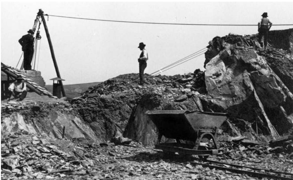
Imagem 25 – Grande plano da vagoneta que servia para transportar matérias de um lado para o outro. Veem-se ainda trabalhadores da obra e, a julgar pela indumentária, à esquerda, um engenheiro a observar os trabalhos.
