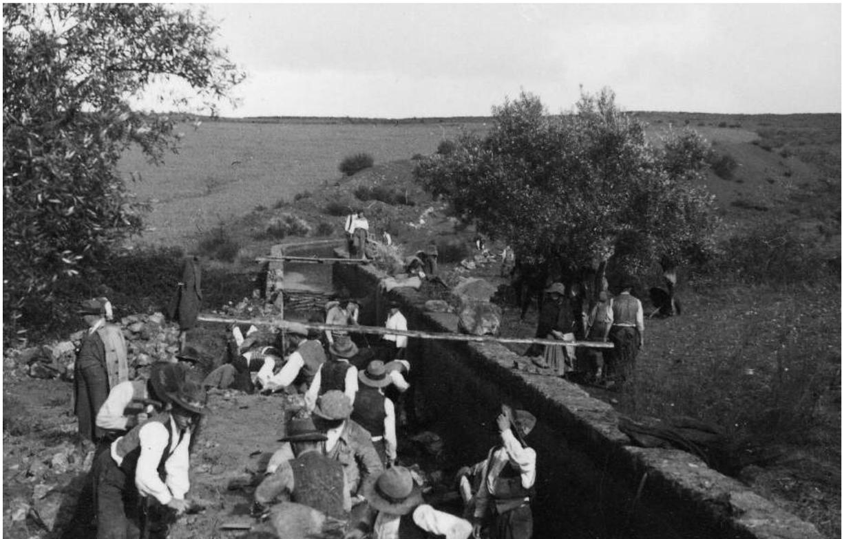
Imagem 26 – Imagem de homens construindo uma conduta forçada. Nesta imagem é possível ver a indumentária usada pelo trabalhadores da construção, em tudo semelhante à que usavam para o trabalho no campo. Sobre o lado direito podemos ver uma *aguadeira*, a única mulher que surge nas imagens da construção.
