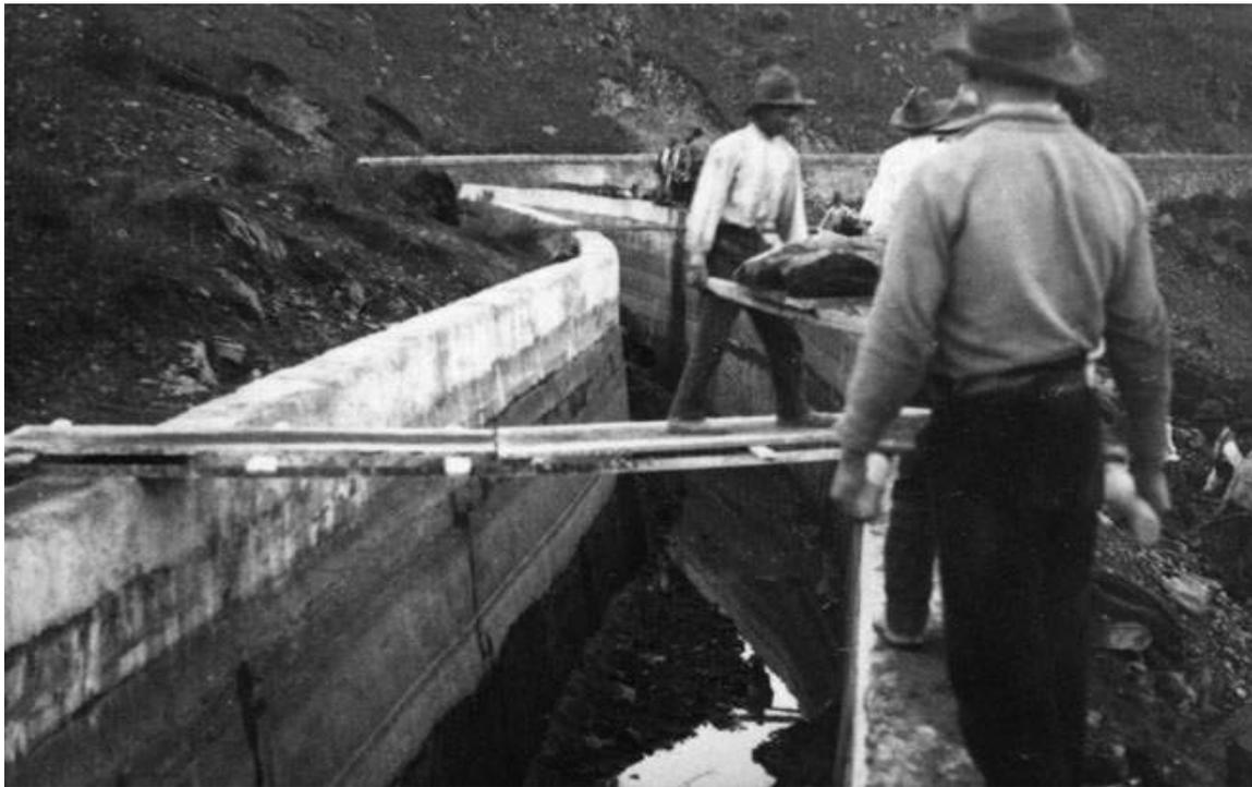
Imagem 27 – Imagem de homens construindo uma «conduta forçada» que servia para conduzir a água entre as centrais. É possível ver uma *padiola*, um importante instrumento de trabalho, que permitia transportar grandes pesos numa altura em que quase tudo era feito à mão.
