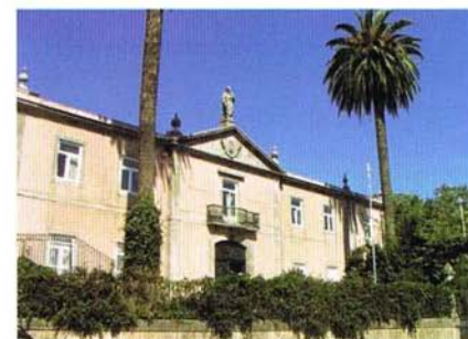
Fig. 11 - Edifício que serviu de Asilo da Mendicidade do Porto, vendo-se no remate a alegoria da Caridade, recorrente em vários edifícios assistenciais oitocentistas (foto de Francisco Queiroz).
